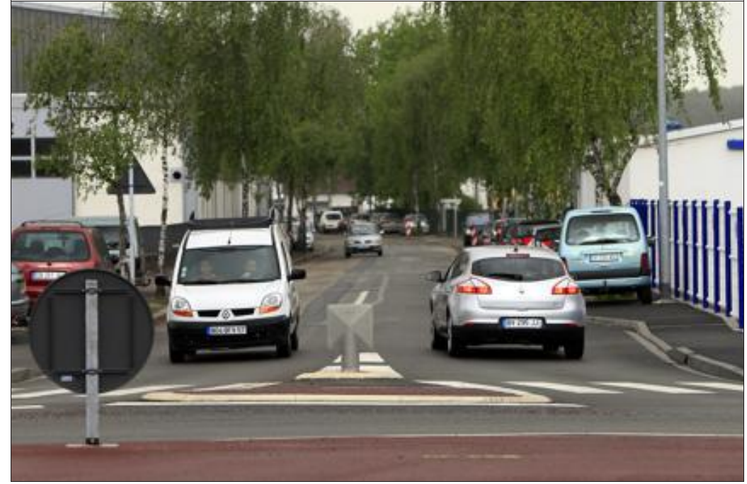
Après la rue Dumaire, c'est la rue Edison qui va être entièrement rénovée. Premier coup de pioche le 29 mai prochain. Photo Thierry NICOLAS.
